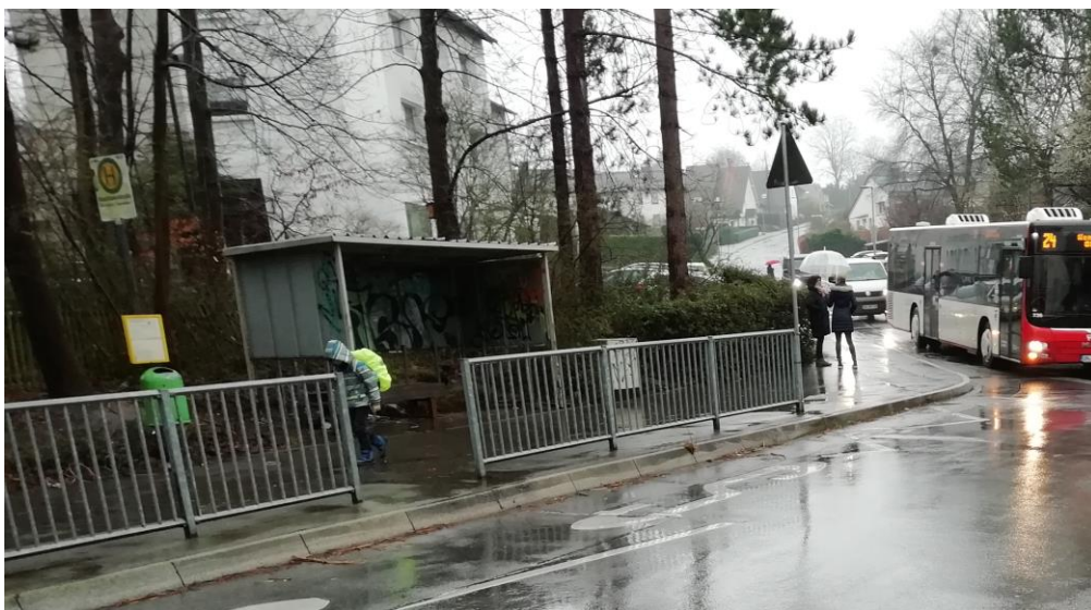
Das Bushaltestellen-Wartehaus in der Beethovenstraße befindet sich in einem schlechten Zustand.
